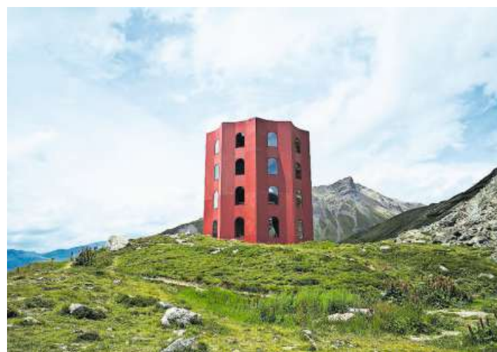
Auf dem Julierpass auf 2300 Metern über Meer steht bis 2020 dieser Theaterturm für das Origen-Festival.
